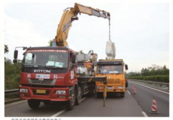
现场补给连续作业微表处施工
