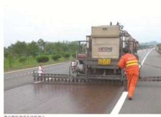
聚合物抗渗再生涂料施工
