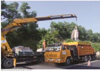
微表处现场补给作业施工技术
