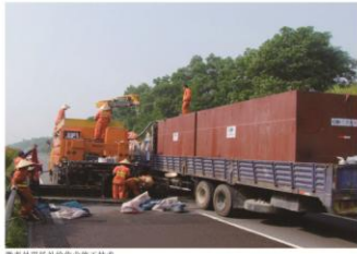
微表处现场补给作业施工技术
