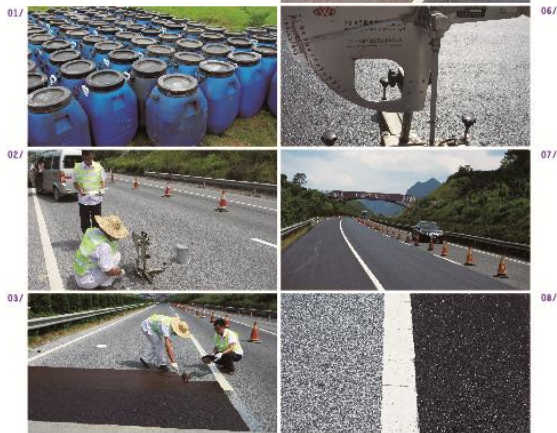
01)NDAP雾封层材料准备；02)原路面性能指标检测；03)单位面积洒布量确定；04)单位面积洒布量验证；05)NDAP雾封层洒布施工；06)NDAP雾封层后路面性能指标检测；07、08)NDAP雾封层施工完成后路面表现
