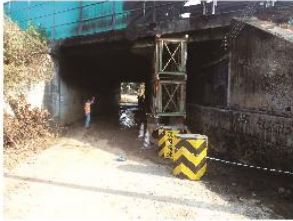
01/临时加固立面图 02/桥缝加固
