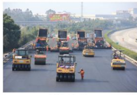
摊铺碾压施工现场
